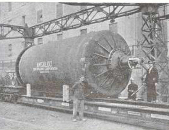
Tamburo piombato costruito dalla Carpenteria per la Società «Rumianca» di Torino (stabilimento di Massa)
